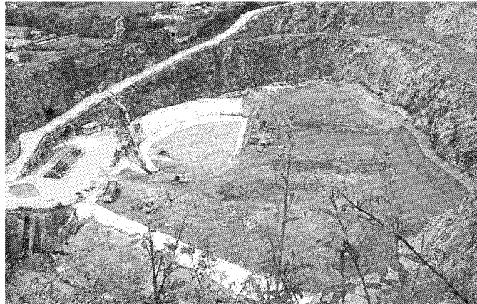
Una veduta di Cava Fornace
