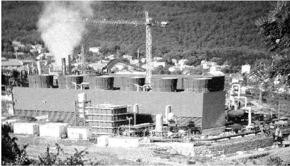
La centrale geotermica Bagnore 4, a Santa Fiora
