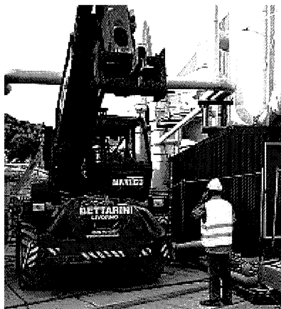
INTERVENTI Alcuni lavori in una centrale di geotermia. In questi giorni saranno molteplici
